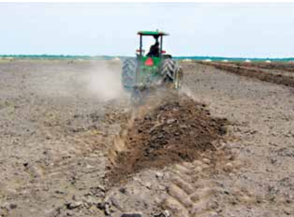
Figura 40. Construcción de bancales.
