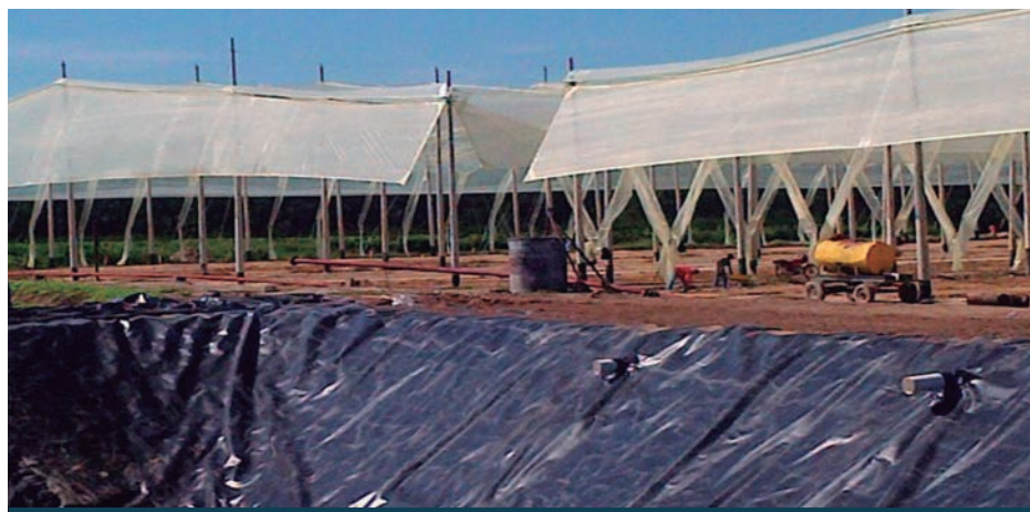
Figura 6. Impermeabilización de lagunas y proyecto de compostaje en una empresa palmera del Cesar.
