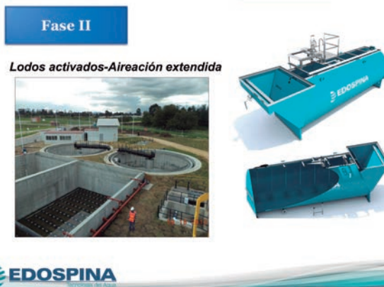
Figura 12. Sistema de lodos activados / aireación extendida de EDOSPINA.
