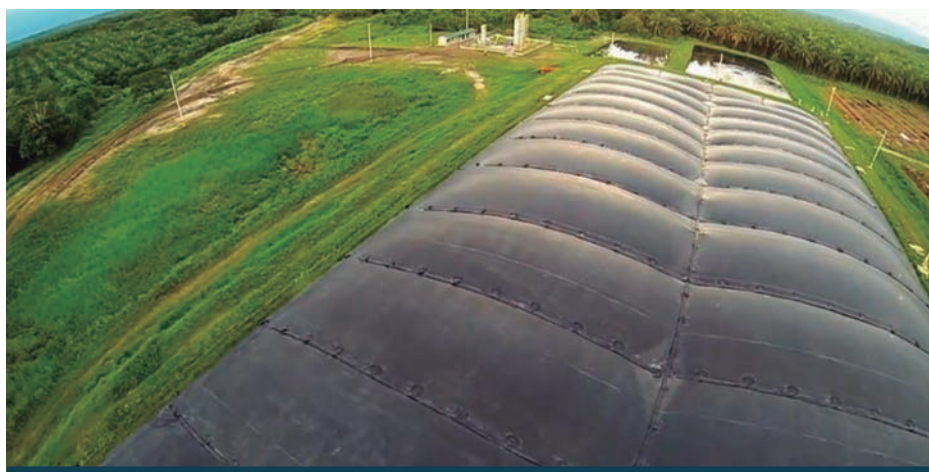
Figura 4. Laguna carpada para la captura de metano en la planta de C.I. Tequendama S.A.S.
