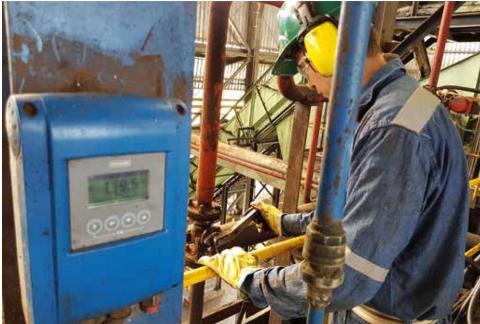
Figura 17. Operador ajustando factor de dilución.
