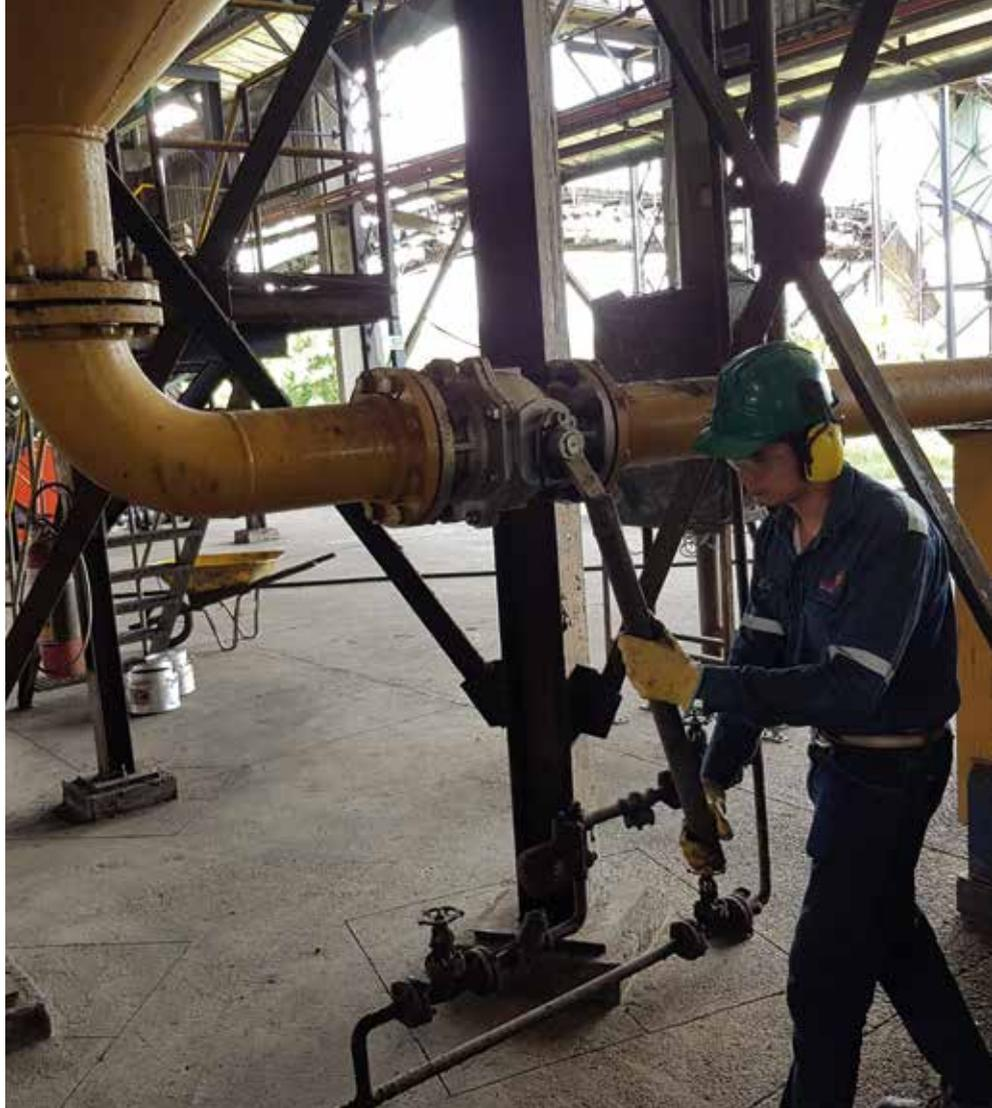
Figura 15. Operador realizando purga de clarificadores.
