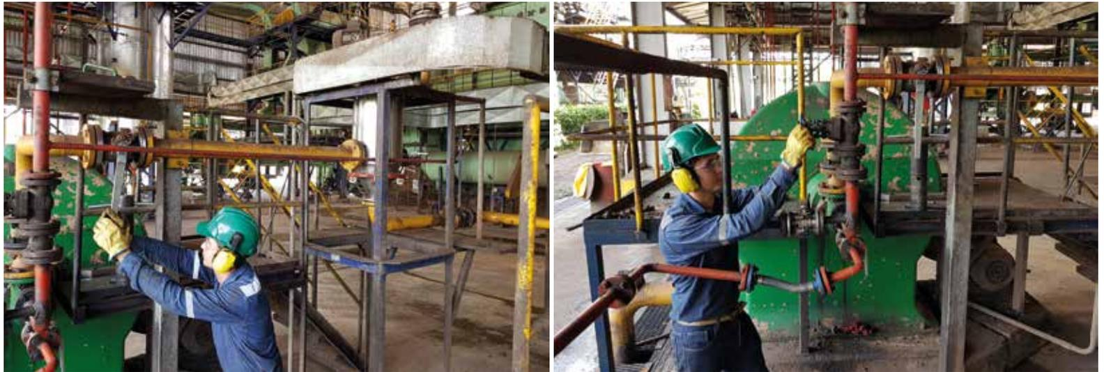
Figura 30. Operario cerrando válvulas de lodos, de recuperado y de agua
