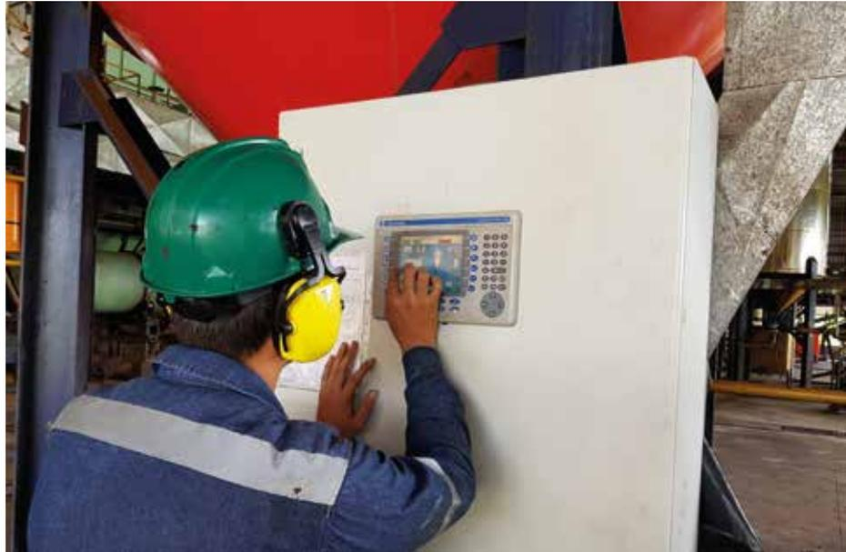
Figura 22. Operador desenergizando módulo de clarificación.
