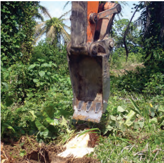
Figura 15: Erradicación mecánica por medio de una excavadora.
