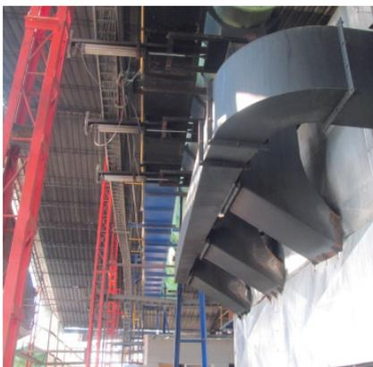
**Figura 3.** Compuertas de alimentación de biomasa.
