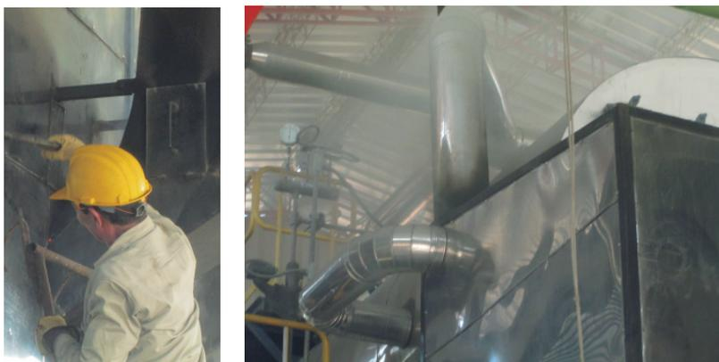
**Figura 5.** Revisión del estado de los aislamientos.
