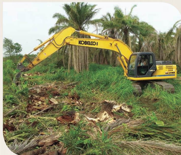
Tumba mecánica de palmas con retroexcavadora. Foto: Oliverio Agudelo.
