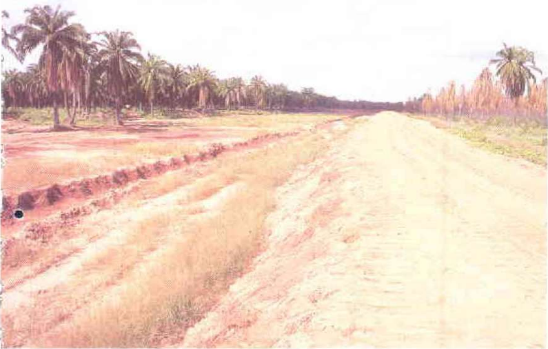
Construcción reservorio - Palmas Oleaginosas de Casapará Ltda
