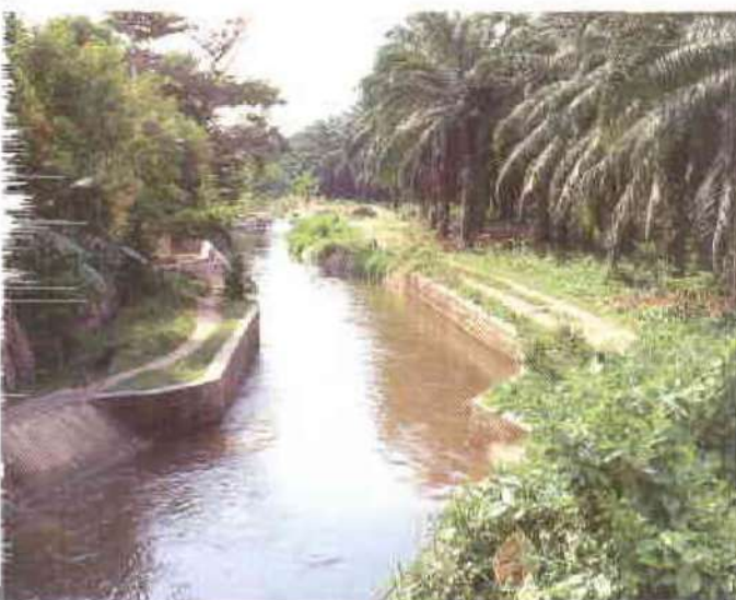
Canal para riego - Río Aracataca.
