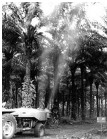
Fotografía 36. Equipo terrestre de fumigación con turbinas de alta potencia en plantaciones adultas mayores de 20 años. Tratamiento contra Caeloenomenodera elaeidis . Costa de Marfil, África. (Philippe Genty, 1966)
