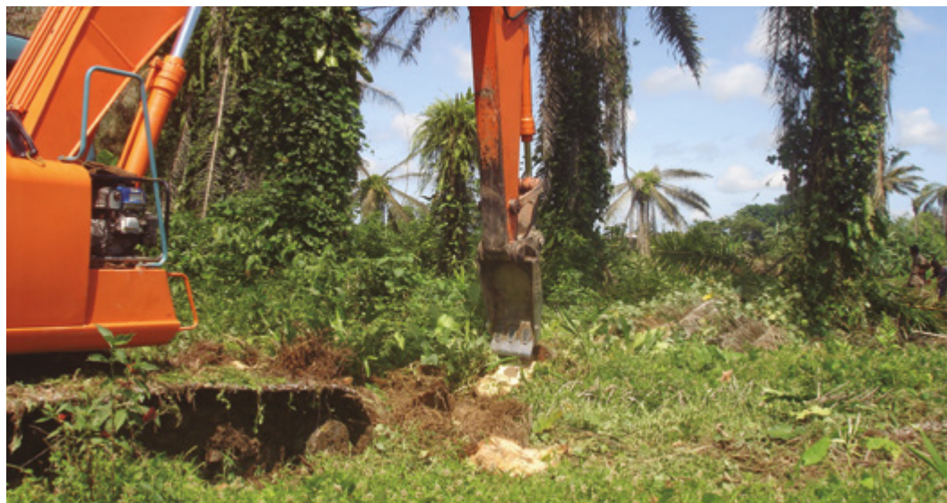
Figura 15. Máquina excavadora realizando el picado de los estípites de palmas de aceite infectadas con PC. Foto: J. Aldana |
