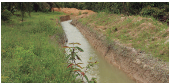
Figura 20. Limpieza y mantenimiento de drenajes.
